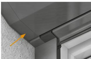
Es ist darauf zu achten, dass die Revisionsblende jederzeit zu öffnen ist. Bei INTEGO Elementen, die vor dem Verputzen montiert werden, sind beidseitig 17 mm Friese ab Werk angebracht. Friese sind fest an die Blendenkappen montiert und nicht zu öffnen.
