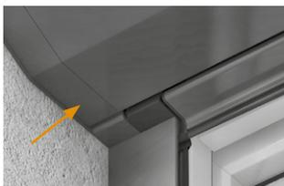
Es ist darauf zu achten, dass die Revisionsblende jederzeit zu öffnen ist. Bei INTEGO Elementen, die vor dem Verputzen montiert werden, sind beidseitig 17 mm Friese ab Werk angebracht. Friese sind fest an die Blendenkappen montiert und nicht zu öffnen.
