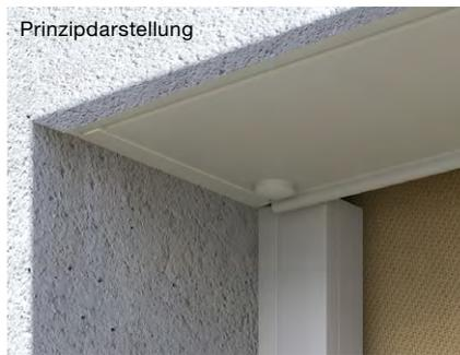
Es ist darauf zu achten, dass die Revisionsblende jederzeit zu öffnen ist. Bei allen INTEGO Elementen, die vor dem Verputzen montiert werden, sind hierzu beidseitig Friese ab Werk angebracht. Bei PENTO mit Revision unten gehören sie ebenfalls zum Standard!
