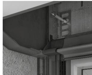
Kastenzusatzbefestigung bei Panzergewicht über 20 kg (Abb. XP-System)
